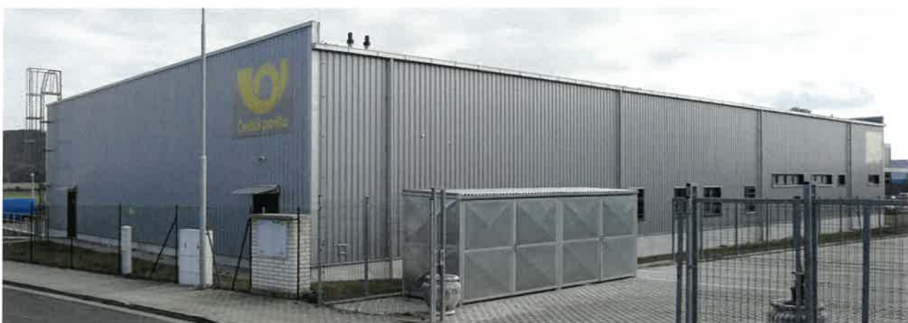
KONSTRUKCE HALY Z PREFABRIKOVANÉHO BETONOVÉHO SKELETU THE CONSTRUCTION OF THE HALL IS MADE OF PRECAST CONCRETE SKELETON
